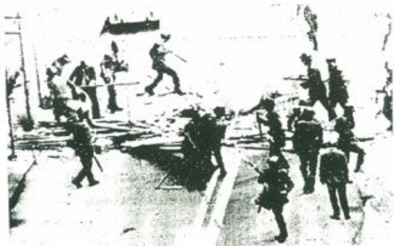
La policía debía intervenir para abrir paso y remover los escombros de las barricadas levantadas por el Movimiento de Izquierda Revolucionario (MIR), para obstruir el tránsito.
